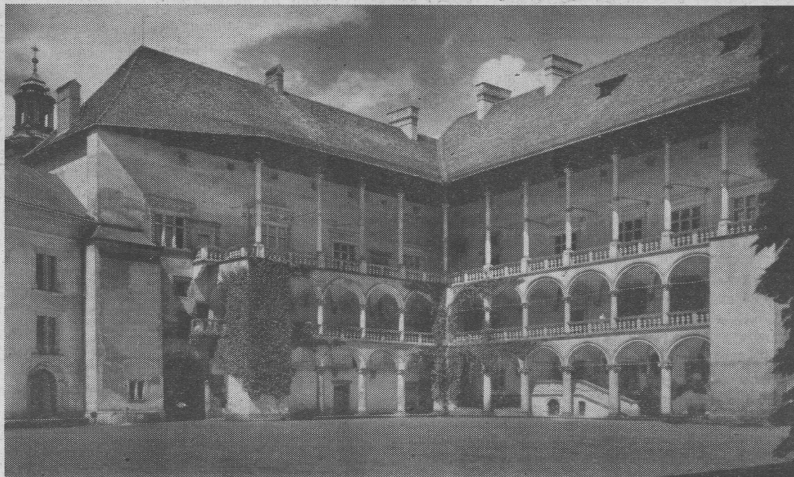
Dziedziniec renesansowego pałacu. Zdjęcie wykonane oczywiście podczas lata.
