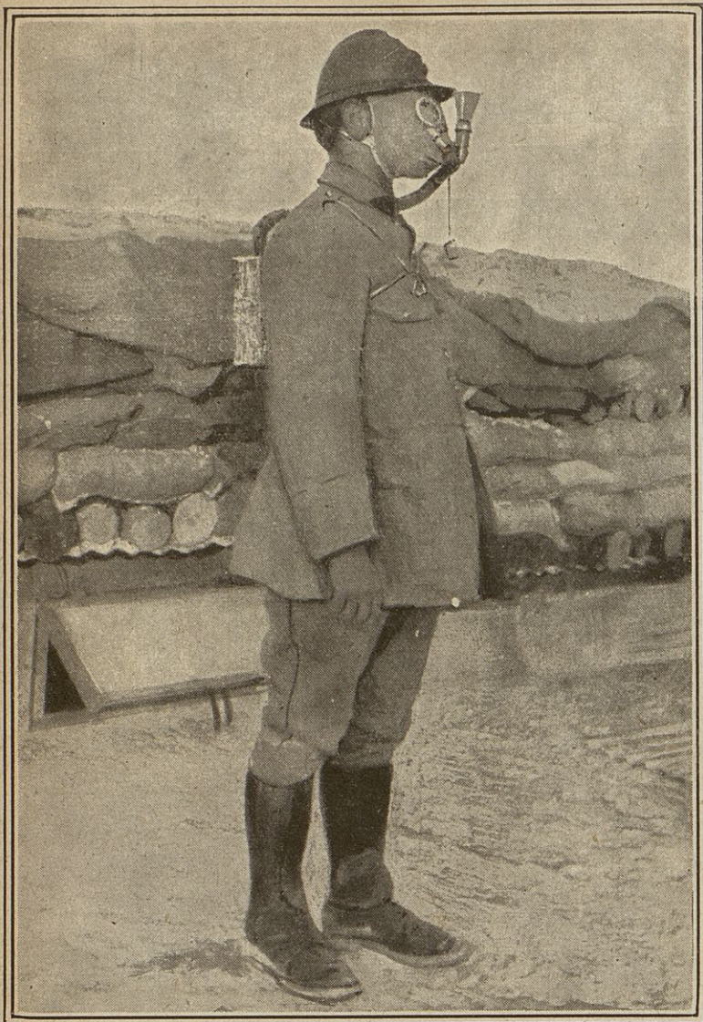
Un officier muni de l'appareil Tisot, vu de profil : on s'en sert pour visiter l'intérieur des abris.
