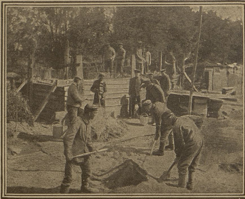
Un revêtement de madriers est appliqué contre l'armature ; à mesure qu'il monte contre les parois, le ciment y est coulé.
