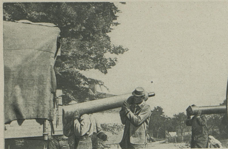
ON APORTE LES TUBES DE GAZ
