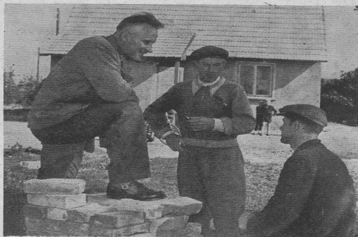
W Zielonogórskim pierwsza „agronomówka” stanęła w Gorulsku. Mieszka tu agronom Fr. Kościuk (pierwszy od lewej)
