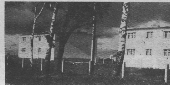
A oto i „czworaki”. W każdym mieszkaniu łazienka z ciepłą wodą bieżącą
