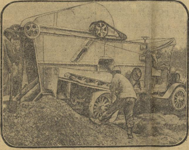
Nouvelle auto dragueuse creusant une tranchée de 2 mètres 50 de profondeur. Photo BLANC
