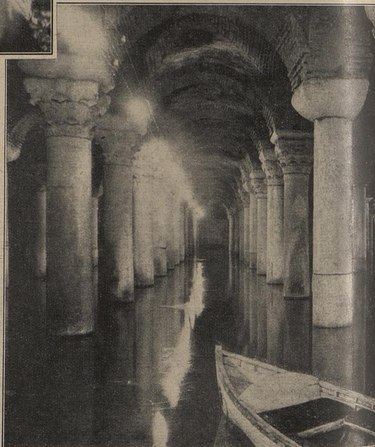
Die „Gewölbe der 1001 Säulen“ werden Luftschutträume.
