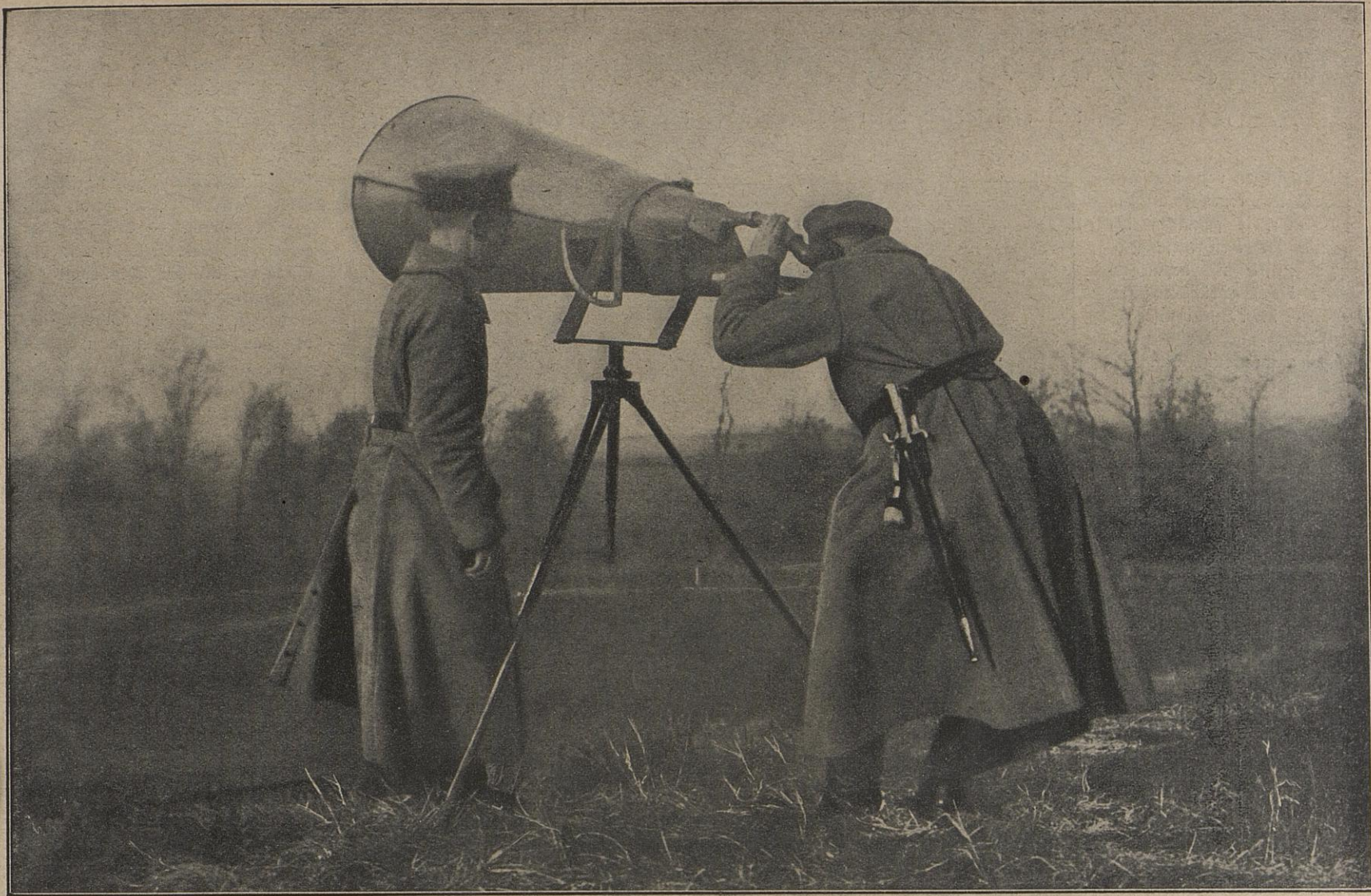
Bei unseren Fliegern: Sorchapparat, mit dem die Annäherung feindlicher Flugzeuge festgestellt wird.
