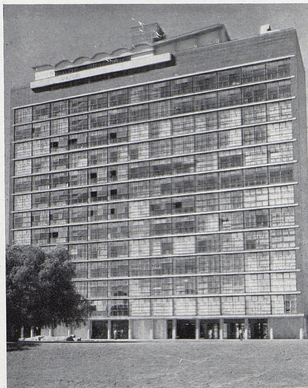
Bâtiment de la Cité Universitaire où se trouve installé l'Institut.
