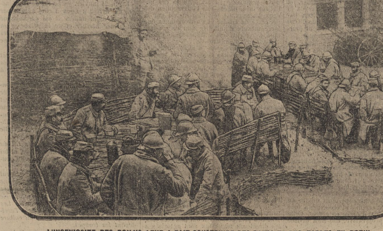
L'INGÉNOSITÉ DES POILUS LEUR A FAIT CONSTRUIRE DES BANOS ET DES TABLES EN ROTIN
