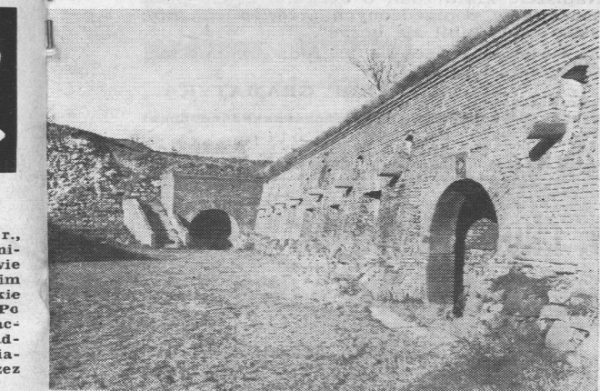
Fragment obszernego dziedzina szczytowej części jednego z licznych fortów warowni. Z zewnątrz mury tworzą jedną całość z prostopadłą ścianą skalną
