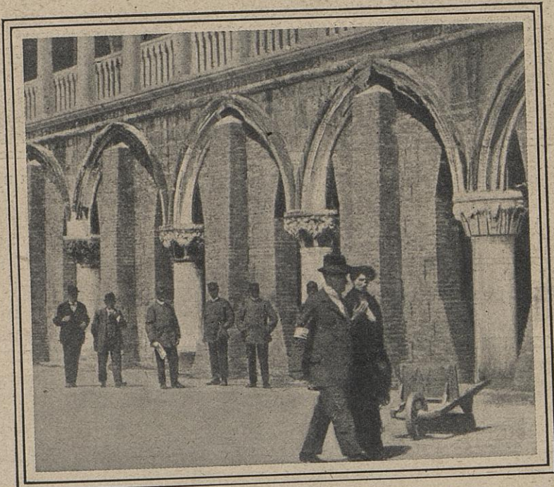
Steinsäulen unter den Bogen des Dogenpalastes in Venedig zum Schutz des Gebäudes bei Fliegerangriffen. Aus einer italienischen Zeitschrift.
