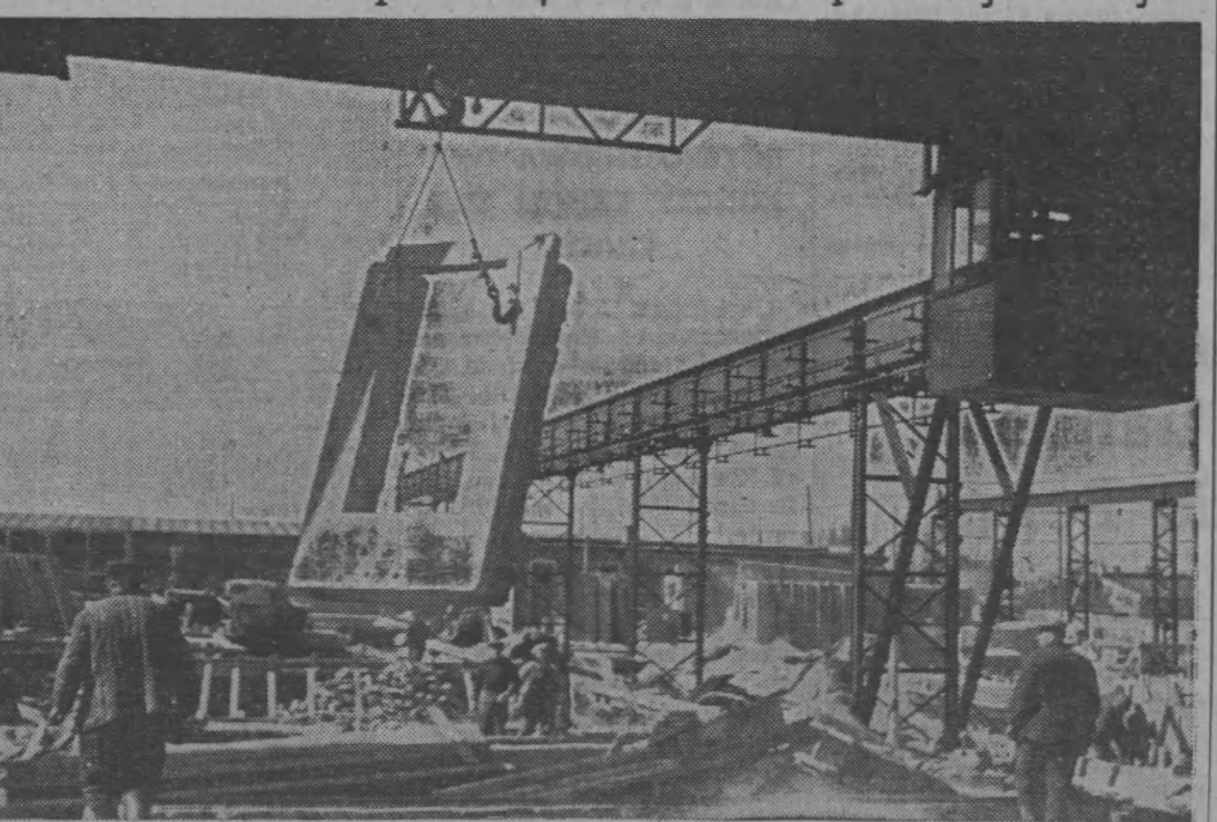
Na zdj.: Fragment nowouruchomionych standów do produkcji elementów prefabrykowanych.
