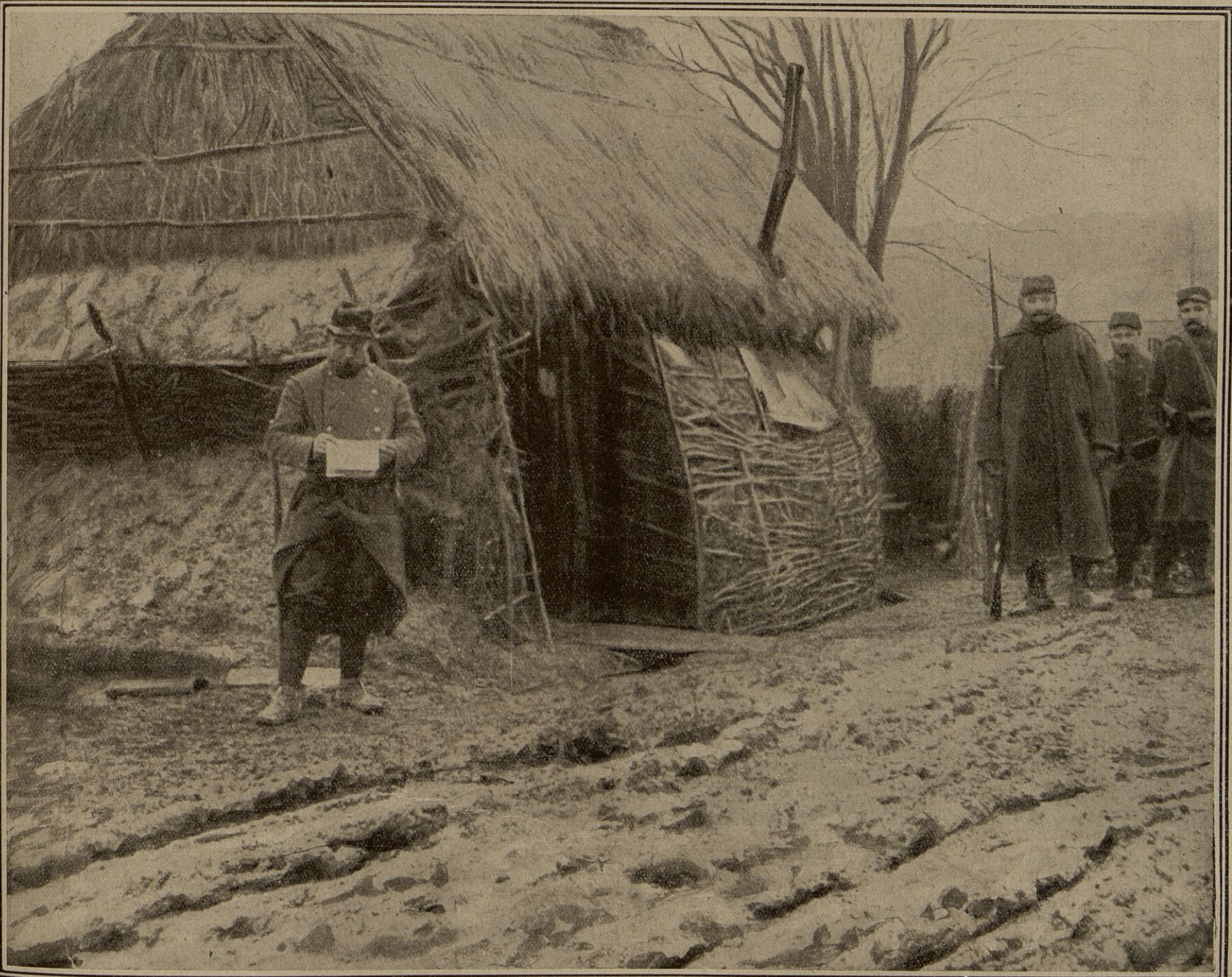
Voilà cinq mois que ce poste, fait de branchages et couvert de chaume, est habité par des territoriaux qui gardent la voie du chemin de fer ; l'abri était solidement construit, car il a résisté à toutes les intempéries.
