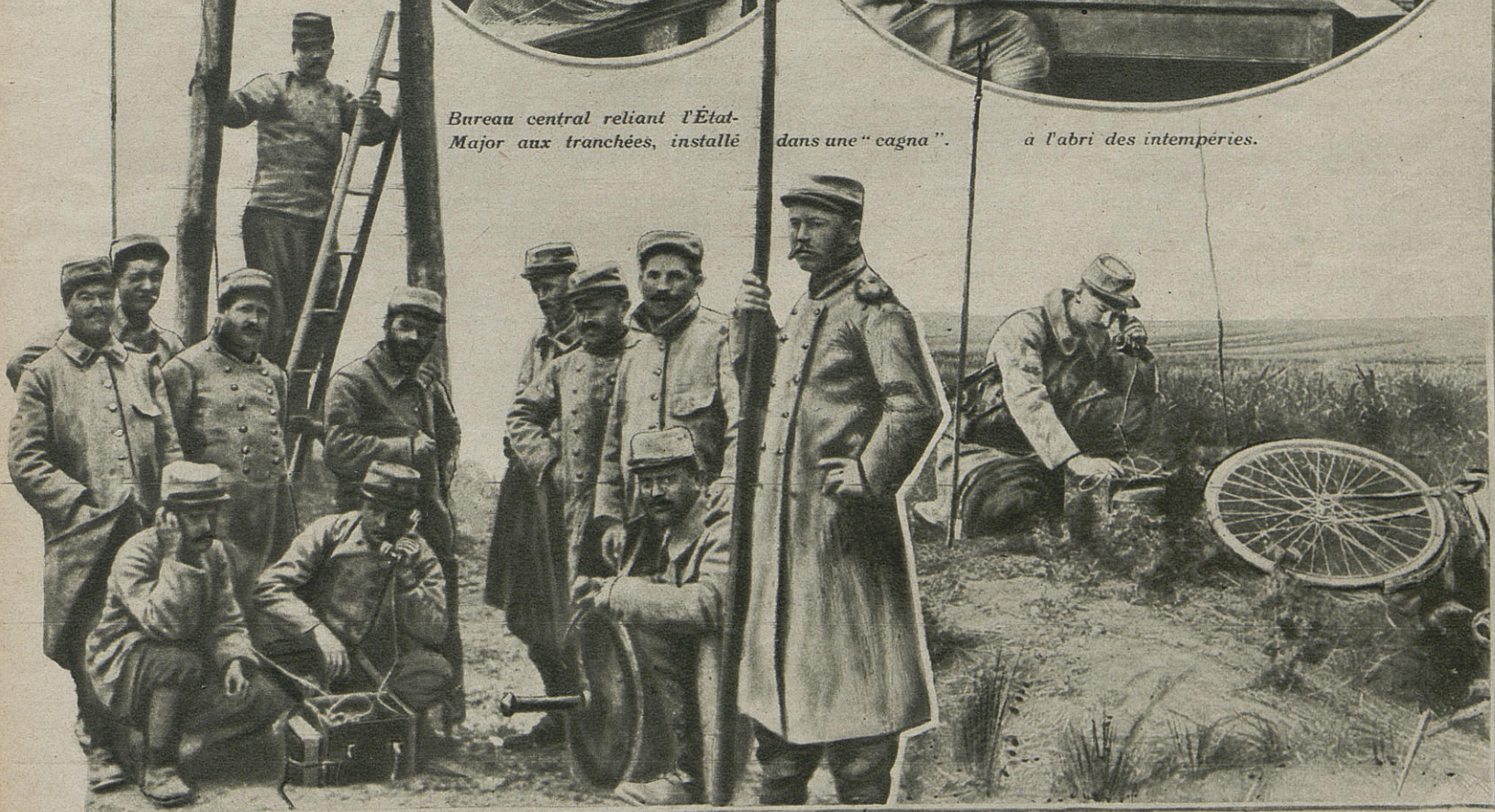
Installation provisoire d'une ligne volante, sur les poteaux fixes de l'Administration des P. T. T.
