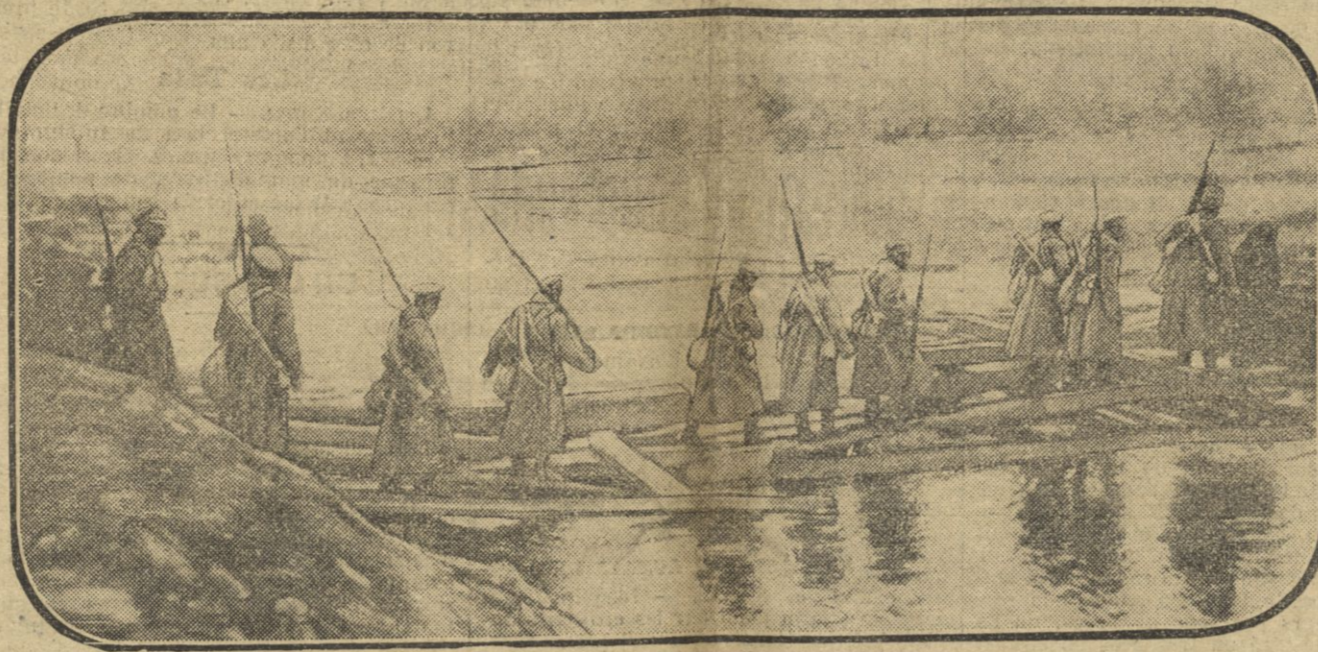
TRAVERSEE D'UNE RIVIERE SUR UN PONT IMPROVISE
