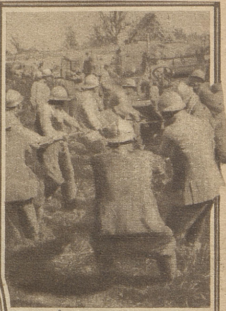
L'automobile d'un officier de liaison est tombée dans un ravin ; des poilus la relèvent et avec des câbles la remettent sur la route.
