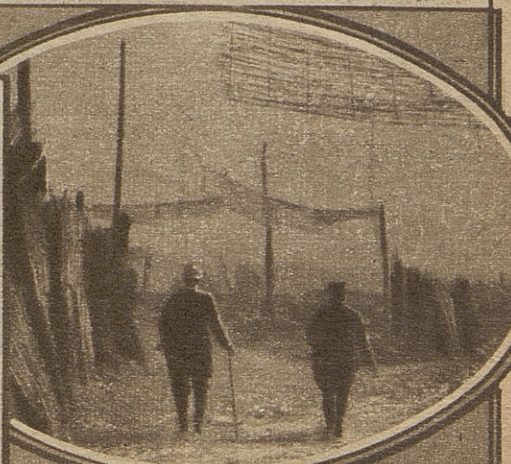
Sur le front de Venétie, une route battue par l'artillerie autrichienne est habilement camouflée par les sapeurs italiens, ce qui permet la circulation libre des renforts.
