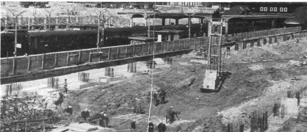
Budowa nowego Dworca Centralnego odbywa się przy pełnym ruchu pociągów Fot. CAF
