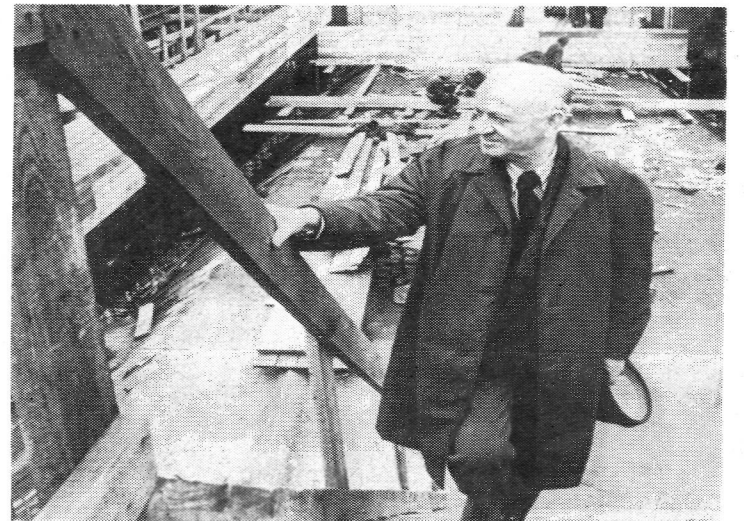
Inżynier architekt Arseniusz Romanowicz jest częstym gościem na terenie budowy realizowanej według jego projektu
