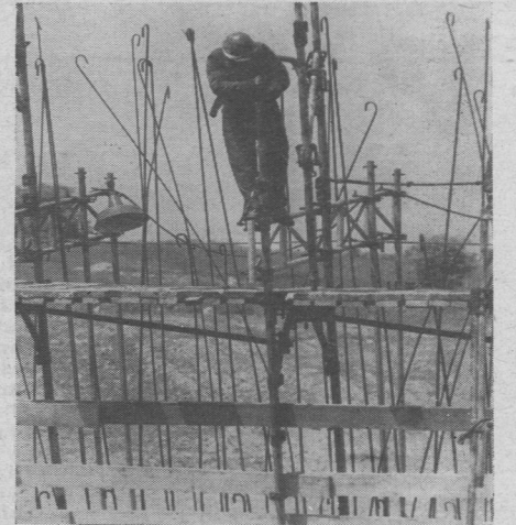
Zbrojmistrze montują ściany żelbetonu
