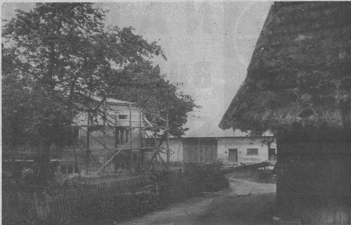
Kontrasty wśród 790 domów Haczowa: stare, pokryte słomą chatynki i nowe murowane domy
