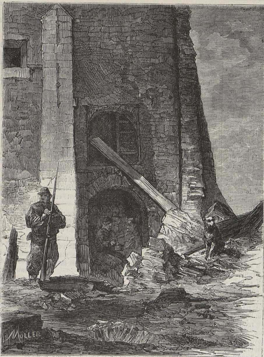
Ruines du château de Chantourterelle, dernier poste avancé, entre Dugny et le Bourget.
