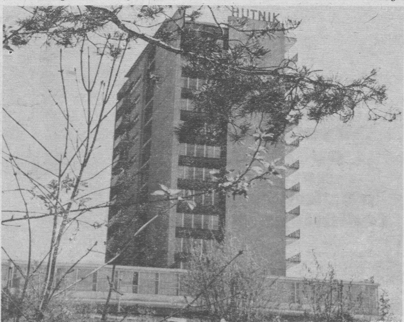
Sanatorium „Hutnik” jest jedną z kilku branżowych placówek w Szczawnicy. Tu leczy się m. in. schorzenia układu oddechowego
