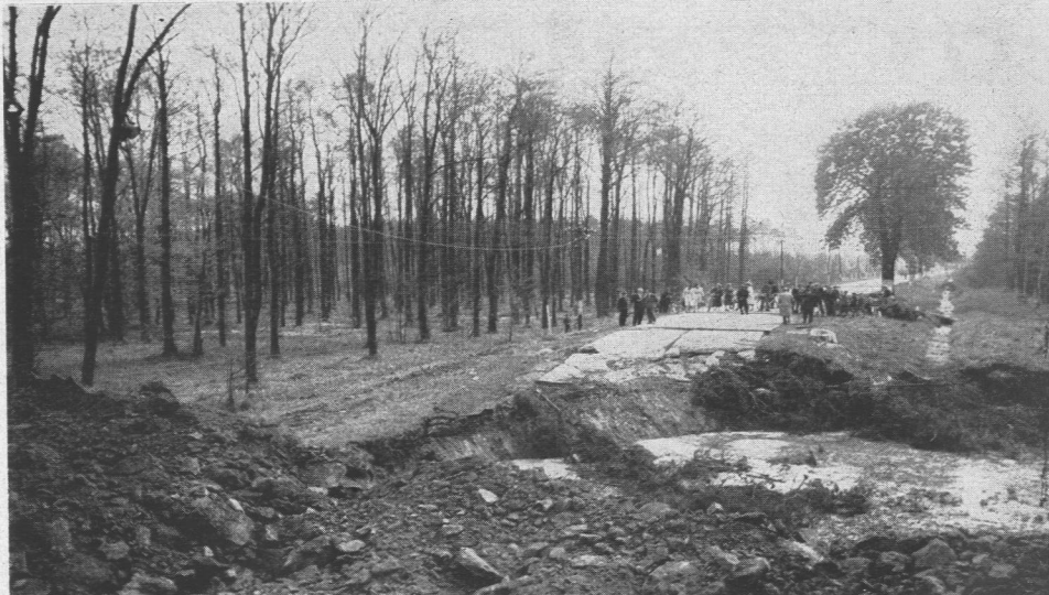
Obsunięcie się starych chodników w jednej z kopalń spowodowało wypadek na szosie Katowice-Tychy. W szosie powstała wyrwa głębokości 70 metrów, długości 427 metrów. Na szczęście nie było ofiar w ludziach.
