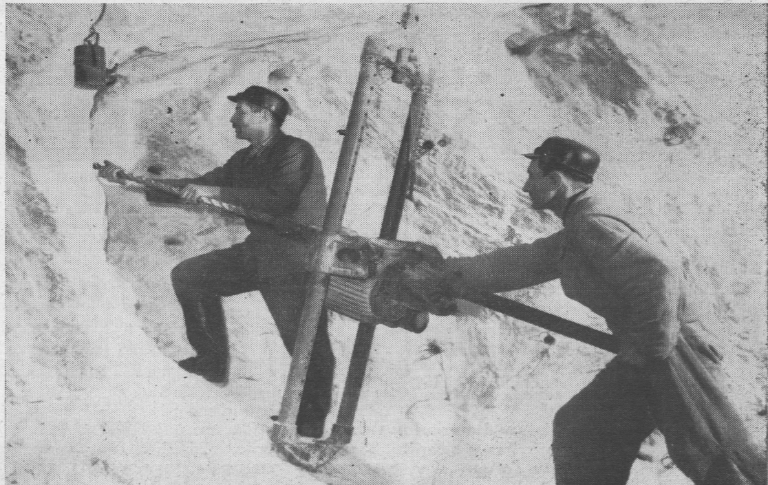
Górnicy przy pracy.
