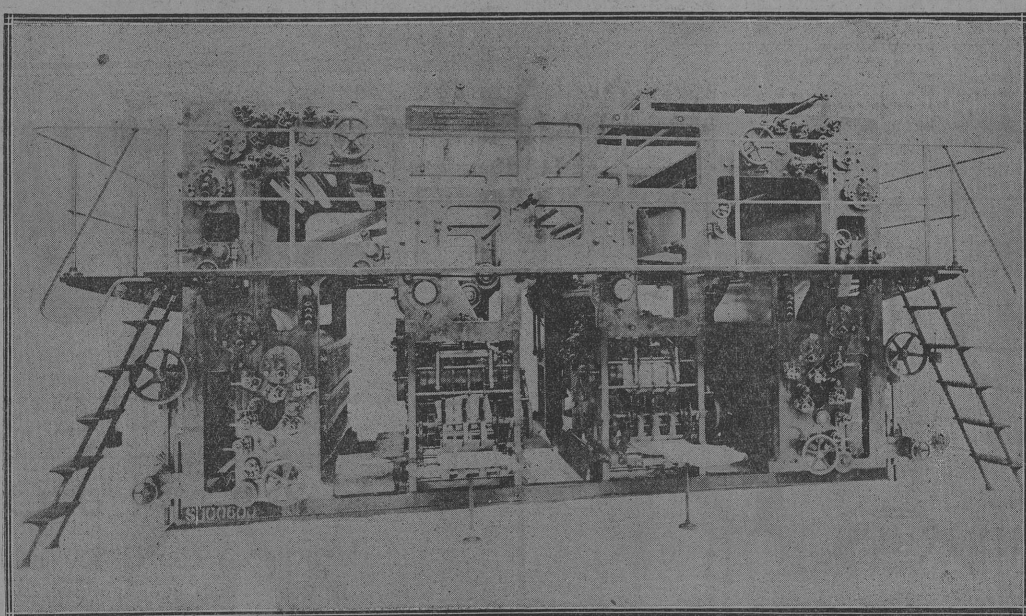
En los talleres de LA VANGUARDIA se instala actualmente esta Rotativa “Augsburg” de último tipo, construida expresamente para las necesidades de este diario. La máquina está dotada de los más recientes perfeccionamientos y trabajará en conjunto con un horno automático de estereotipia, de la misma marca.
