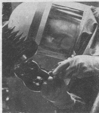
Wnętrze tzw. gorącej komory reaktora oglądać można tylko przez specjalną szybę o grubości 70 cm! Przed rozpoczęciem przeladunku paliwa trzeba sprawdzić manipulatory zastępujące we wnętrzu reaktora atomowego ludzkie ręce. Prace wykonuje się w ochronnym skafandrze
