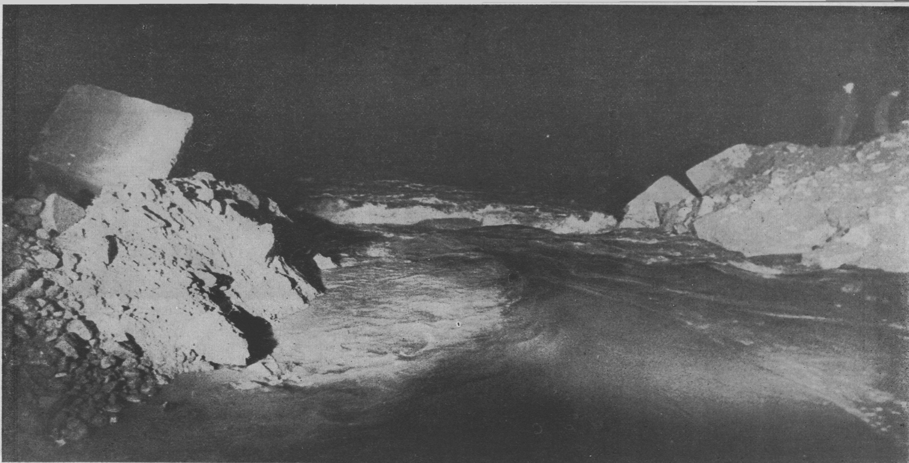
Koryto rzeki zwężone do 10 metrów. Silny prąd z łatwością porywał pięciotonowe bloki betonu. W języku fachowców nazywa się to „przeływ sztyletowy”
