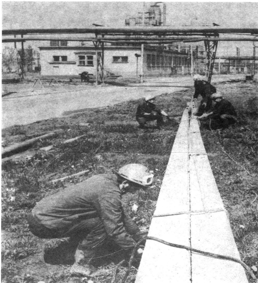
Ostatni potężny słup odgromowy czeka na podłączenie do „powietrznego dźwigu”. 311 start śmigłowca zakończył dwuletni trud odbudowy rafinerii
