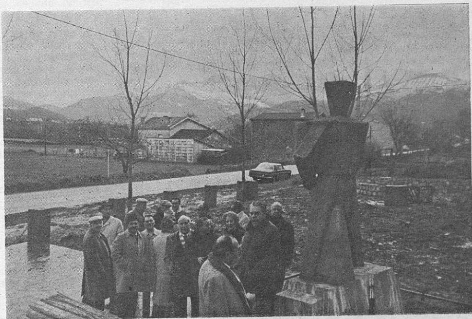
Le monument de Prayols pendant sa construction.
