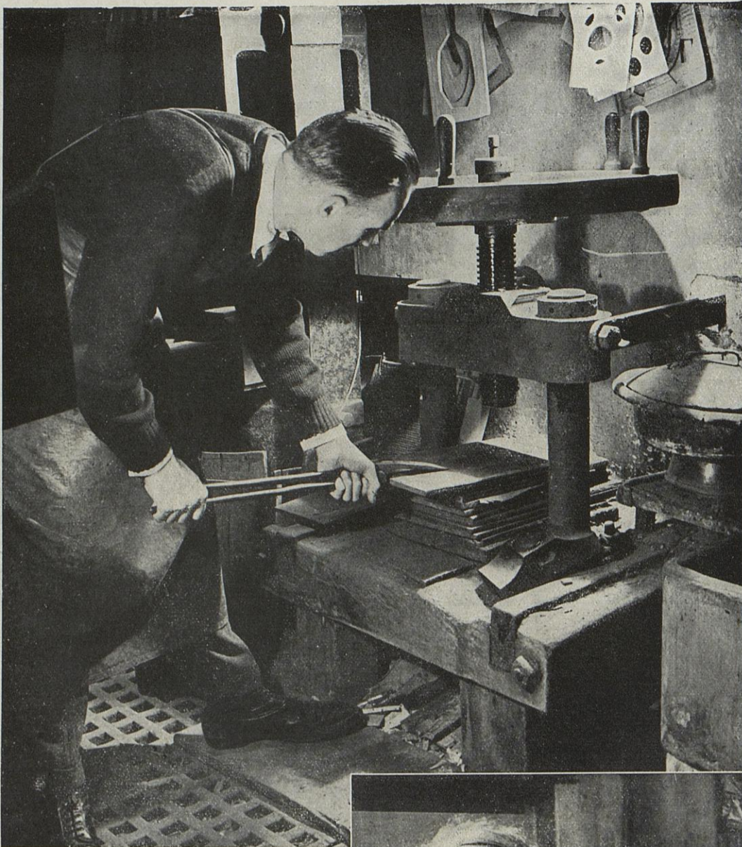
On place les plaques sous la presse à volant.
