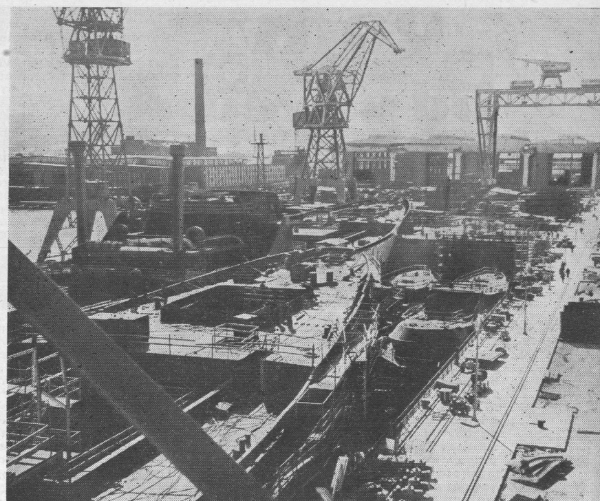
Vue générale de la cale sèche et de ses „quintuplés”. Au fond — le pont-roulant, géant de 500 tonnes de portée
