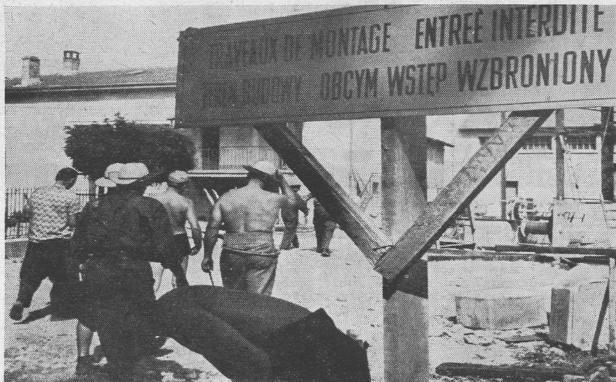
Ustawienie takiego napisu było konieczne. Zbyt wielu znalazło się entuzjastów budowy silosów, którzy z bliska chcieli zobaczyć jak postępuje budowa
