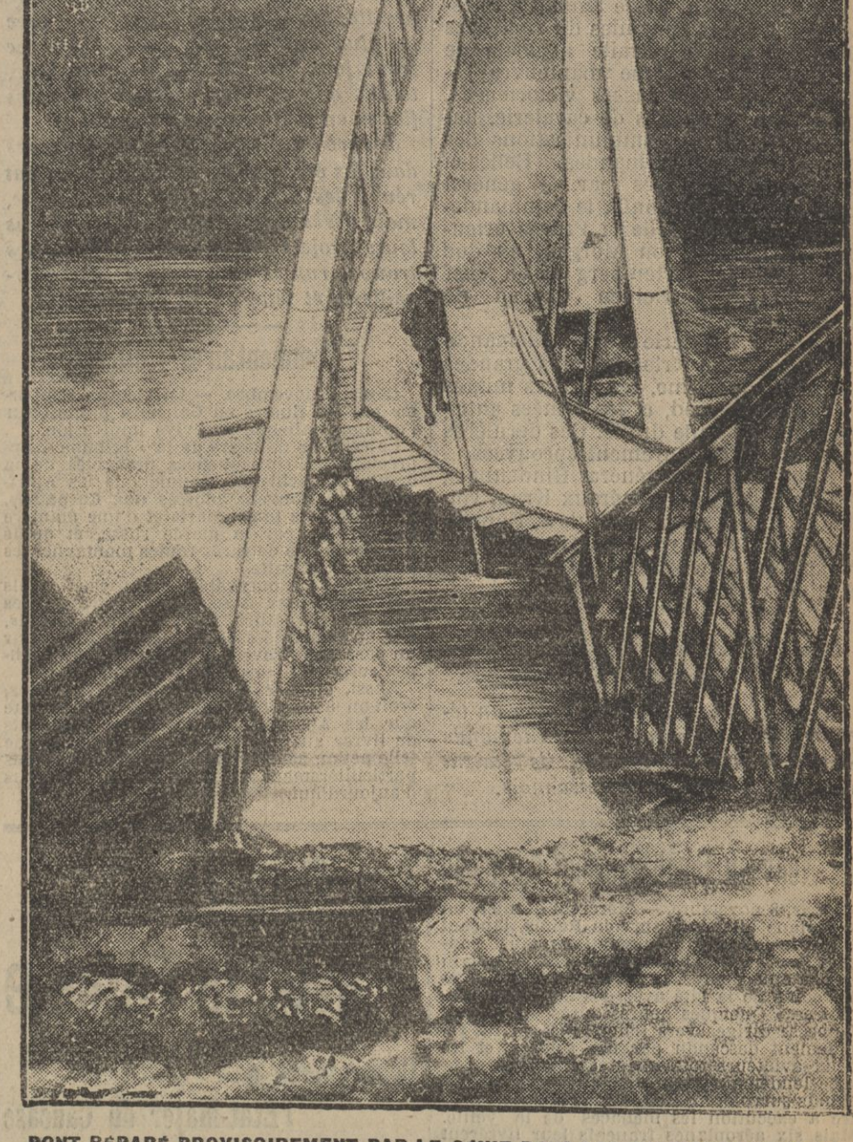
POINT RÉPARÉ PROVISOIREMENT PAR LE GÉNIE DANS LES ENVIRONS DE NOYON
