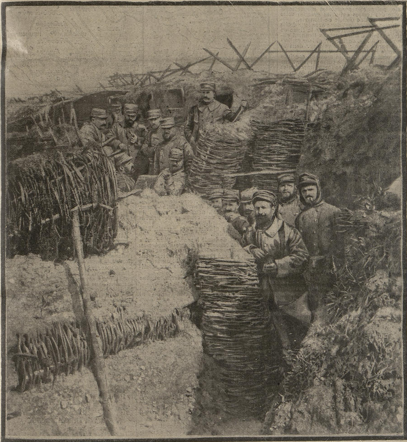
La fascine, moyen de défense constitué de branches entrelacées, était un des systèmes de protection qu'utilisaient les soldats des anciennes guerres pour se garantir dans des positions rendues souvent, ainsi, inexpugnables. La guerre moderne a remis la fascine en honneur, si l'on en juge par cette tranchée qu'occupent et que ne se laisseront pas prendre des territoriaux d'un de nos régiments de l'Ouest qui se couvrit de gloire depuis neuf mois.
