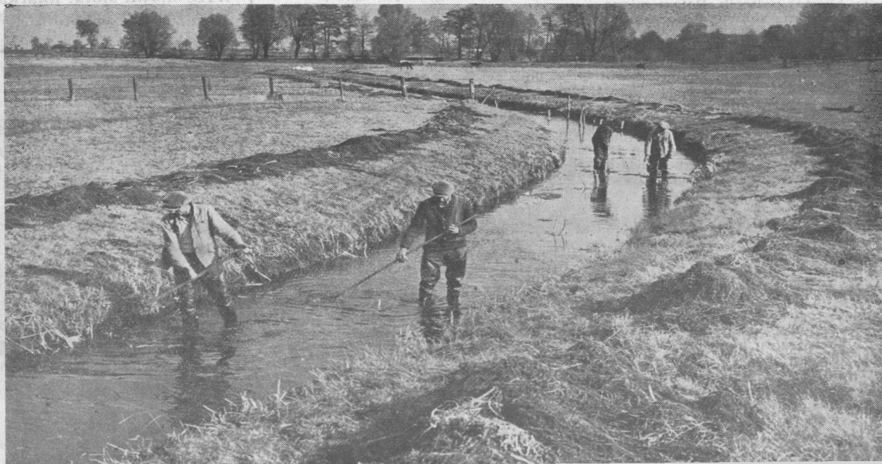
Kiedy sztuczny kanał odpływowy spełnia już zadanie, dla którego został zbudowany, nie można go pozostawić bez opieki. Wtedy bowiem obejmuje go w posiadanie przyroda: bujna roślinność i woda, która przez nanoszenie różnych materiałów sypka dno. Kanał wymaga więc troskliwej konserwacji i systematycznego czyszczenia
