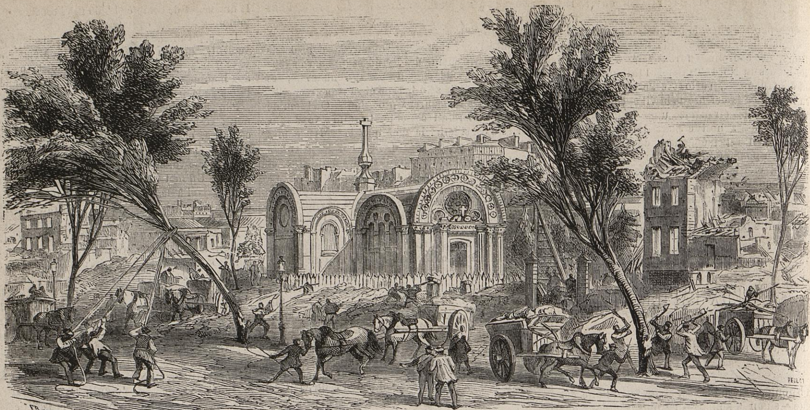
Démolitions des constructions situées dans la zone militaire autour de la chapelle Saint-Ferdinand, route de la Révolte.
