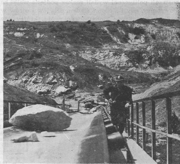
La Pologne est un des plus importants producteurs de machines et d'équipements miniers dans le monde. Un transporteur à ruban dans la mine d'anhydride de Nowy Ląd (notre photo ci-dessus)
