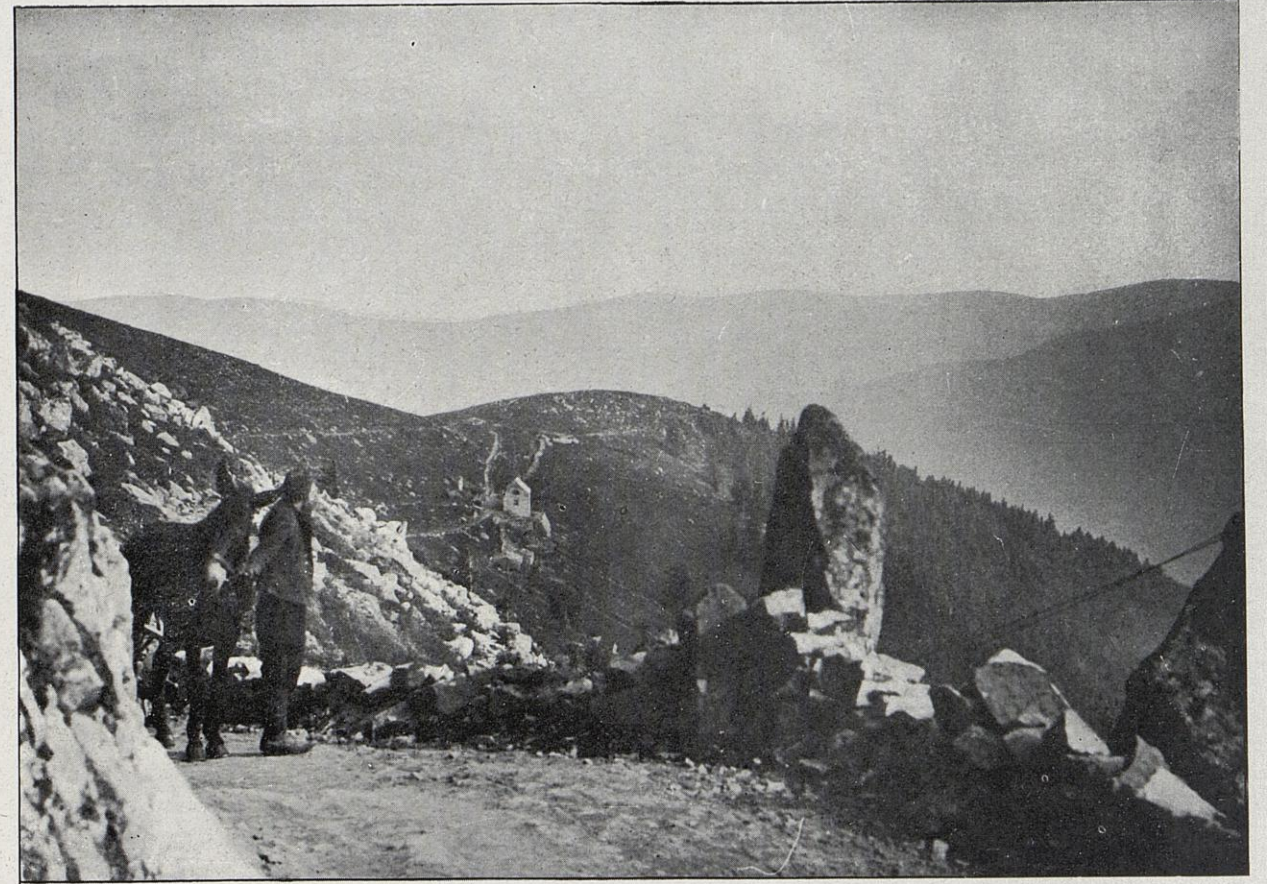
— C'est à travers les routes et les sentiers, sans cesse marmités par l'ennemi, que nos muletiers doivent aller relever les blessés. Leur dévouement s'entoure de précautions de toutes sortes, d'ailleurs nécessaires pour qu'il puisse être efficace.
