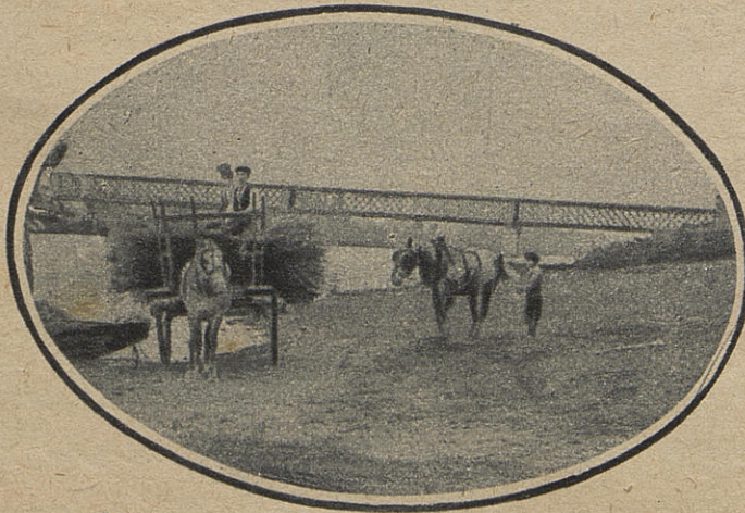
Le pont du Manoir sur lequel passe la grande ligne de Rouen à Paris et que voulait faire sauter le capitaine Stimling.
