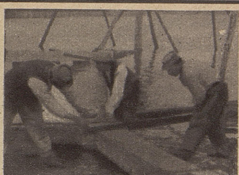
La quille prête, on monte la charpente.
