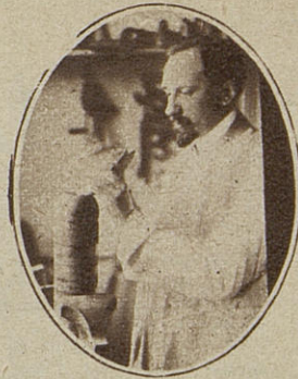
Dévissage de l'ogive d'un obus allemande.
