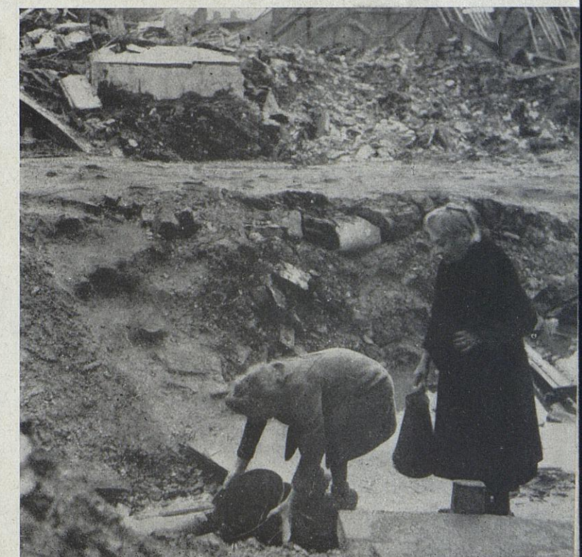
Plus de canalisations : c'est dans la rue que les sinistrés vont chercher l'eau qui permettra de cuire le repas du soir.
