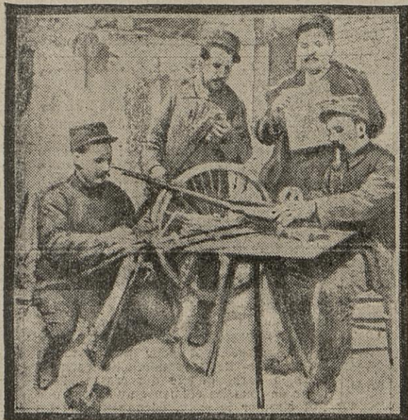
L'ATELIER DE REPARATIONS
