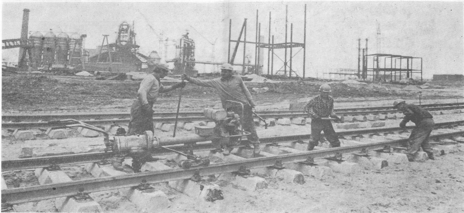
Układanie torów na „linii stali”
