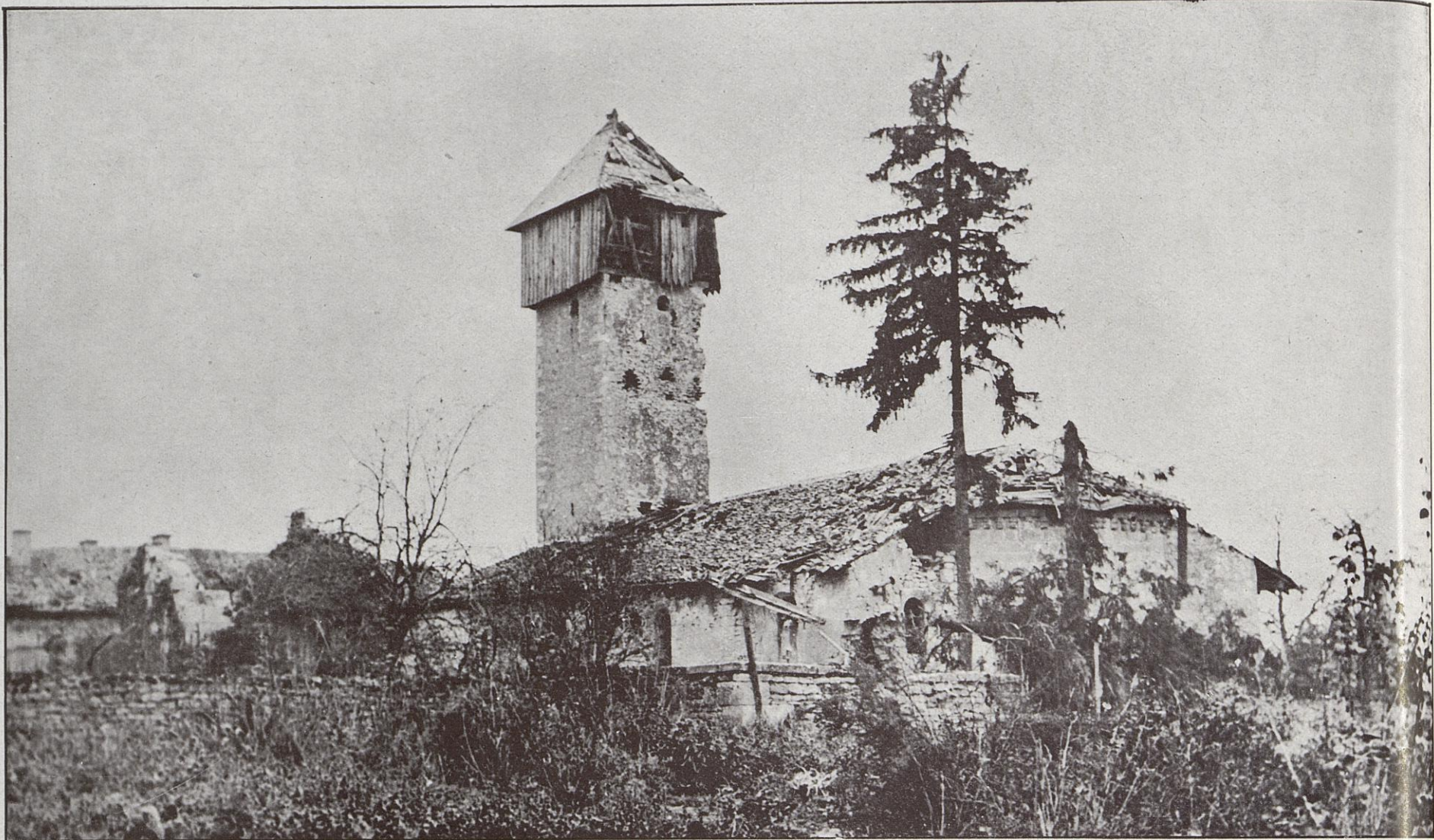
CE QU'IL Y AVAIT DANS LA VIEILLE MASURE. — L'ennemi bombardant tout le pays, prit comme cible cette pauvre mesure délabrée et la tourelle, toute rapiécée qui l'agrémentait si pittoresquement.
