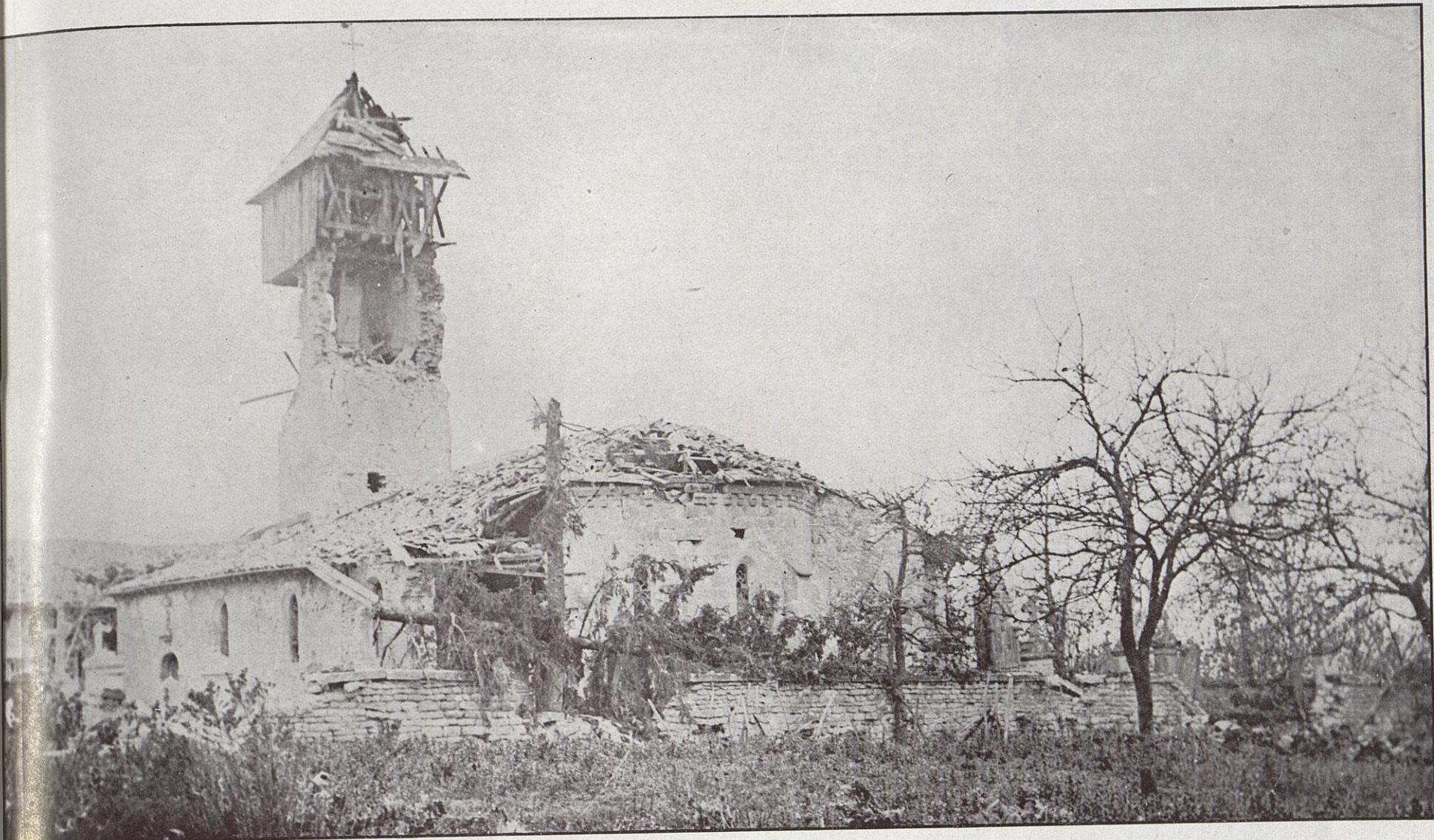
La mitraille continuait furieusement; les pans de mur tombèrent, le toit s'écroula; les poutres et les planchers s'enflammèrent, la tourelle écornée ne tint plus debout que par un prodige d'équilibre.
