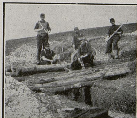
NOS ARTILLEURS A L'ŒUVRE construisant un abri anti-marmitable.
