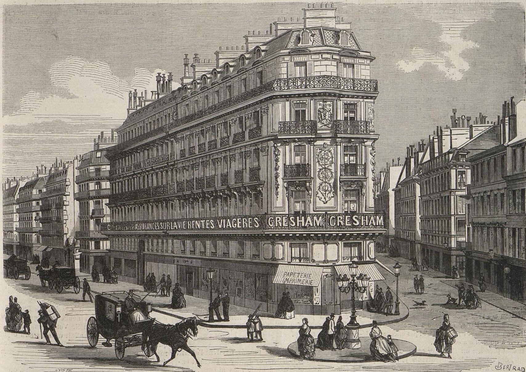
Maison portant le n° 30, rue de Provence. IMMEUBLES APPARTENANT A LA COMPAGNIE GRESHAM
