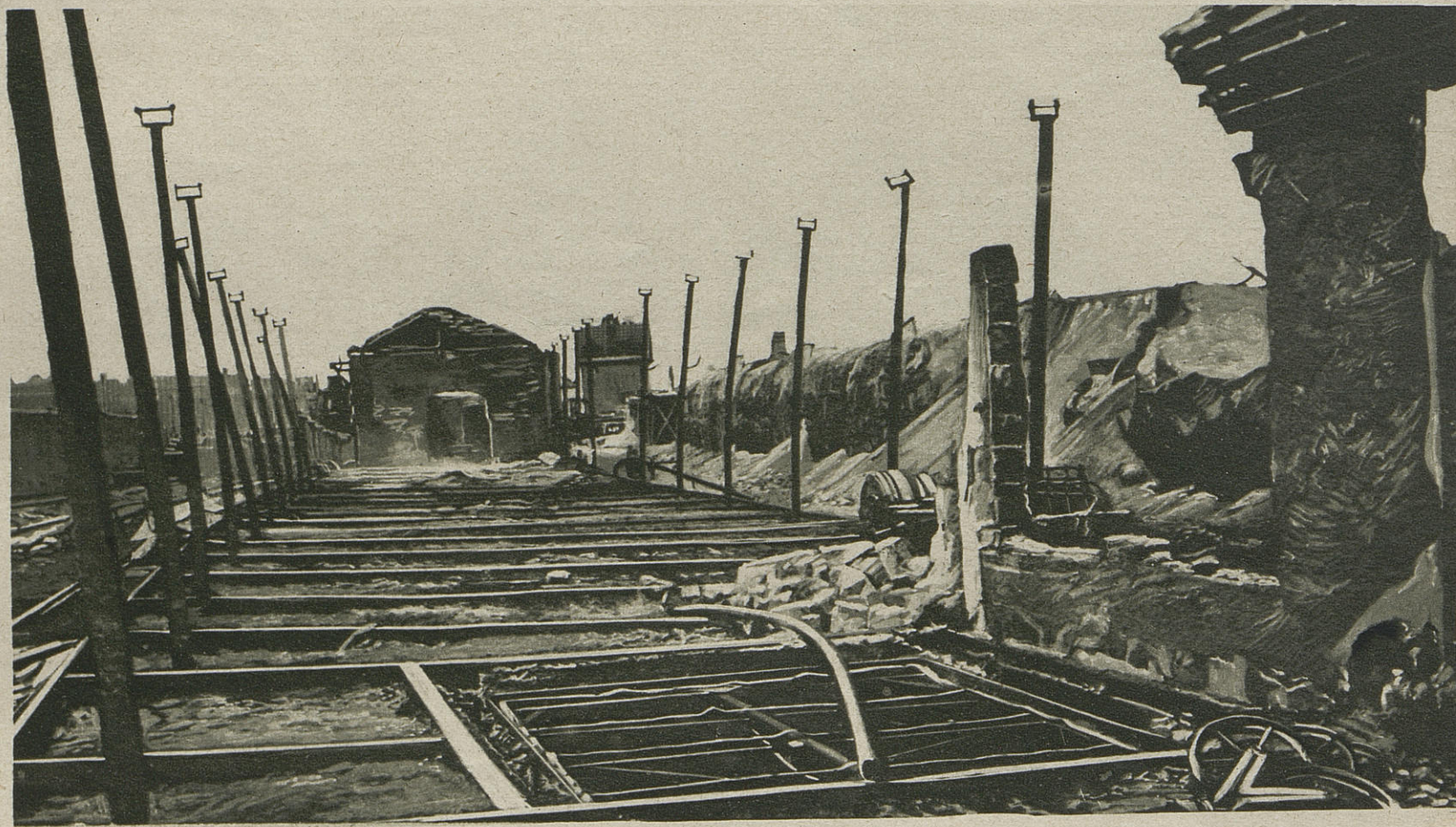
SUR LA LIGNE FERRÉE DE KALISCH A VARSOVIE
