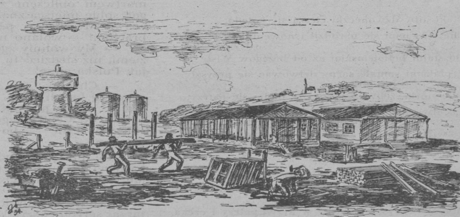
Andrzej Rubinrot: Budowanie nowych baraków
