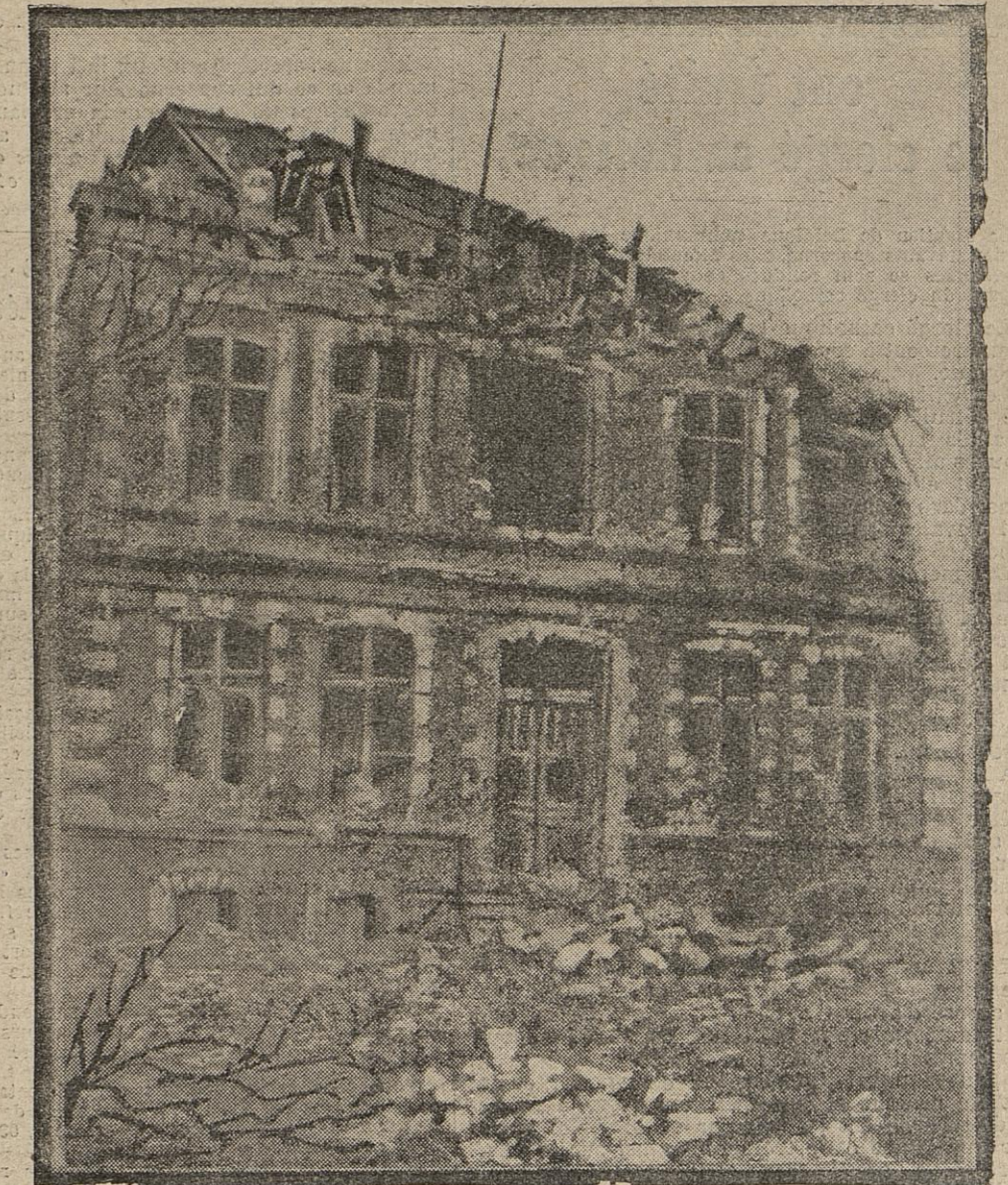
A Vermelles, peu de maisons résistèrent au bombardement ennemi. En voici une qui, quoique fortement éprouvée, a conservé intact son paratonnerre. Nos artilleurs l'ont baptisée : « La Maison du Paratonnerre. »
