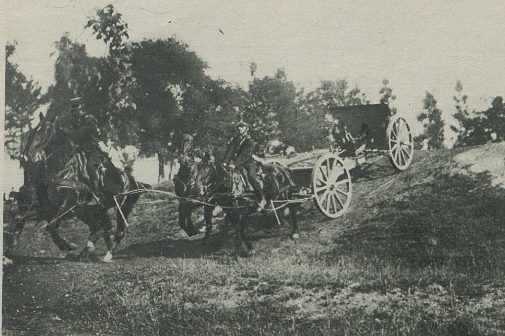
LA MISE EN POSITION D'UNE PIÈCE
