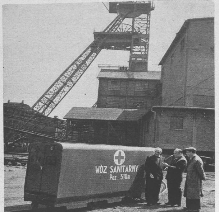
Kopalnia Dębiensko otrzymała pierwszą w Polsce podziemną karetkę sanitarną.
