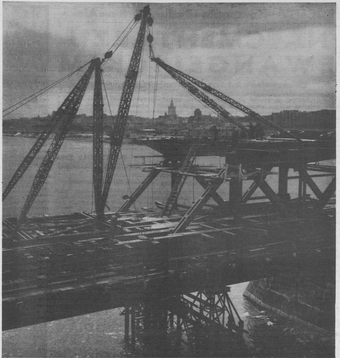
W Warszawie buduje się nowy most pod Cytadela.
