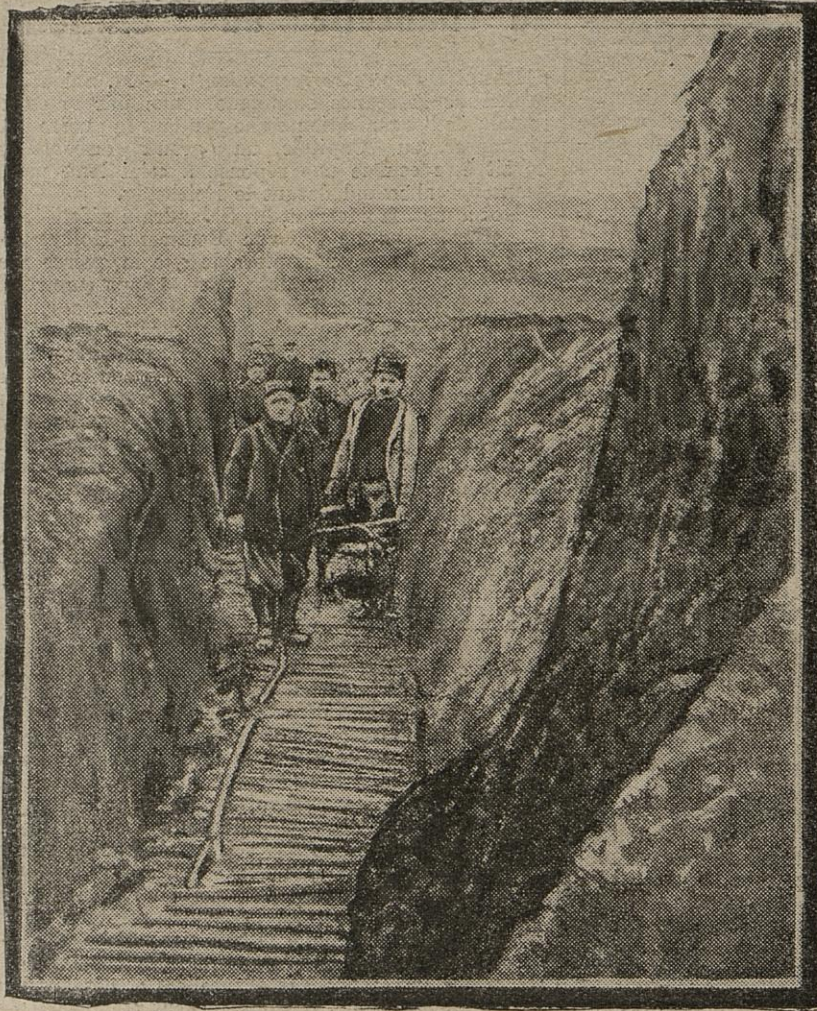
Boyau de ravitaillement qui, long de 1.800 mètres et abouffissant aux secondes lignes, permet de ravitailler les premières lignes, avec le minimum de danger.
